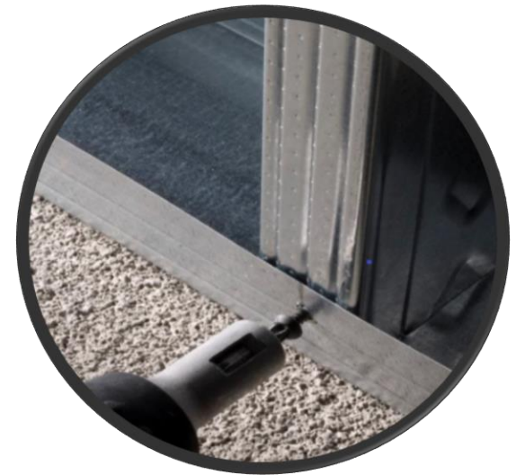
Metal stud sill plate
