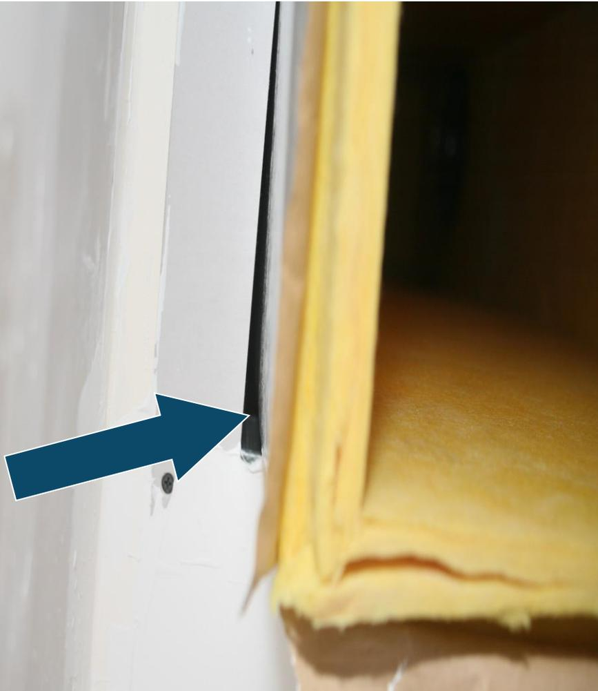
Apertura en el techo detrás de un plenum de suministro de AC que permite que el aire húmedo sucio del ático entre en casa.
