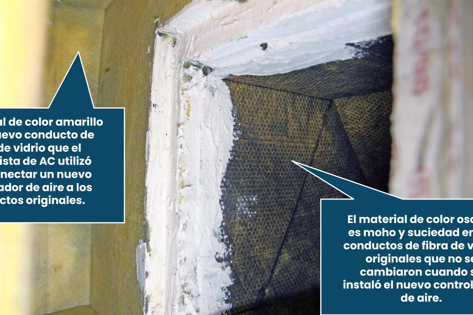
**El material de color amarillo es un nuevo conducto de fibra de vidrio que el contratista de AC utilizó para conectar un nuevo controlador de aire a los conductos originales.**
