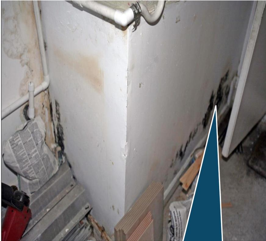
**Moho en el exterior de la caja de aire de retorno del AC. ¡Mucho más moho en el interior!**
