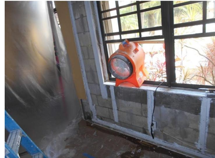
**PRV: No sólo revisar, sino comprobar dentro de la contención para asegurarse de que el moho se ha ido.**
