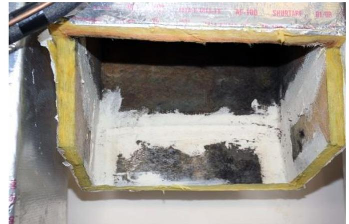
**La fibra de vidrio del plenum de alimentación del AC es el lugar #1 para que el moho problemático se acumule dentro del sistema de AC.**
