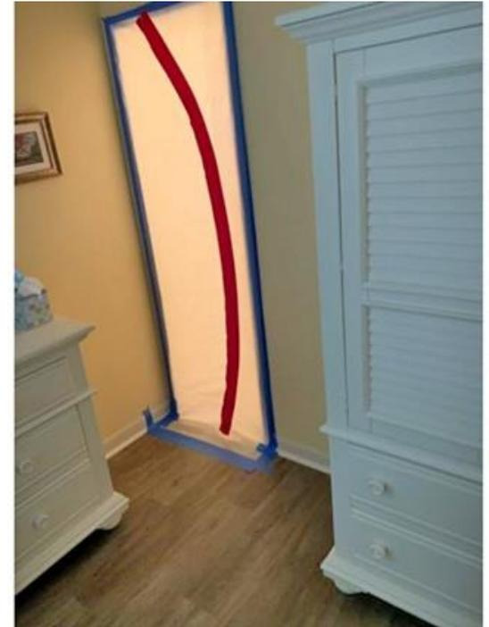
**Las pruebas de PRV suelen estar dentro de un área contenida con un depurador de aire funcionando.**
