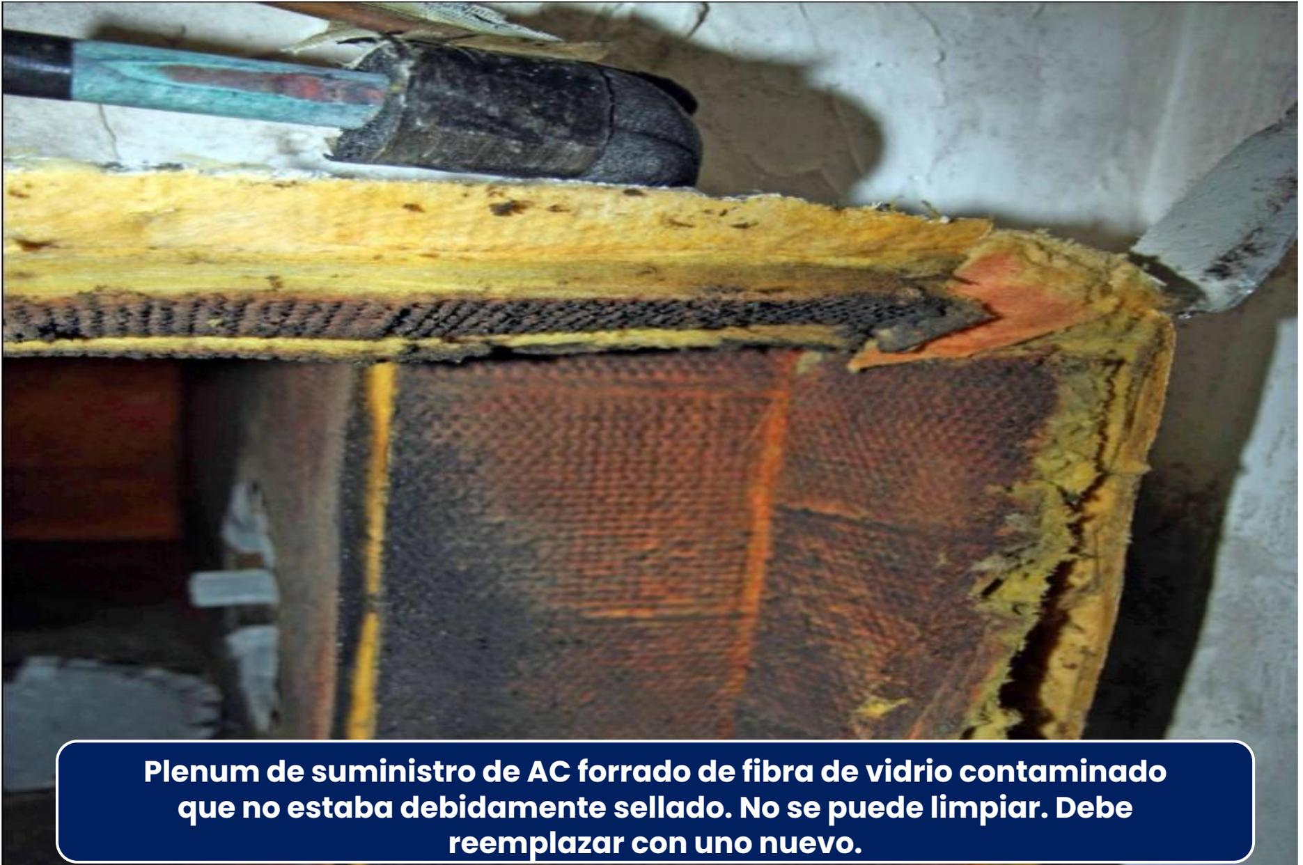
**Plenum de suministro de AC forrado de fibra de vidrio contaminado que no estaba debidamente sellado. No se puede limpiar. Debe reemplazar con uno nuevo.**
