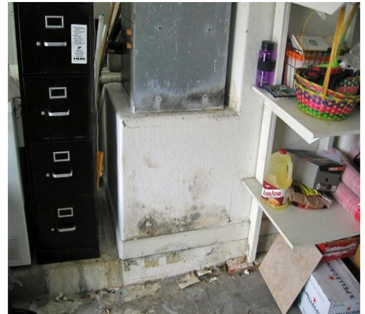
Caja de retorno de AC dañada por el agua con moho tanto en el exterior como en el interior
