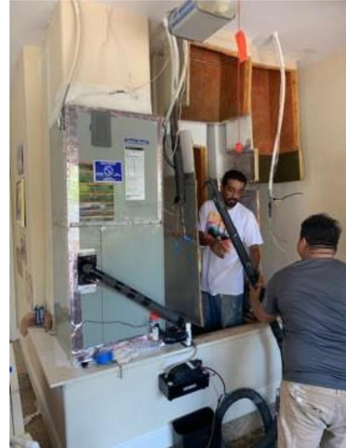
Desarmando y limpiando el ventilador del AC, la bobina, el revestimiento y el plenum.
